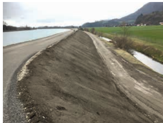
Dammanpassung im Stauraum des Kraftwerkes Nußdorf
