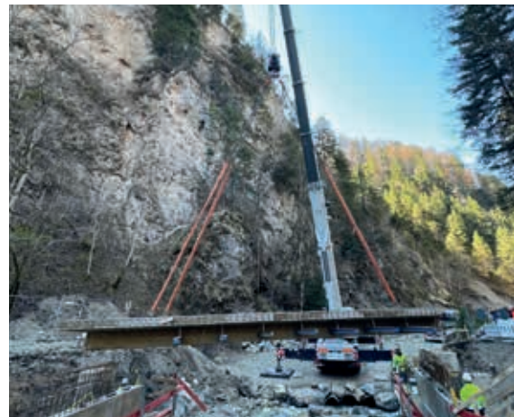
Brückenfertigteile werden eingehoben
