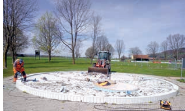
Kinderbecken wird saniert
