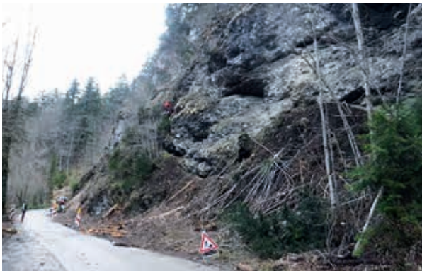
Beräumung an der Sapplwand
