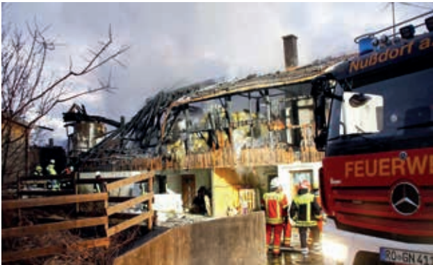
Einsatz am Samerberg beim Bauernhofbrand
